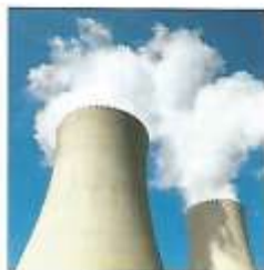
Tours aéroréfrigérantes d'une centrale nucléaire.
